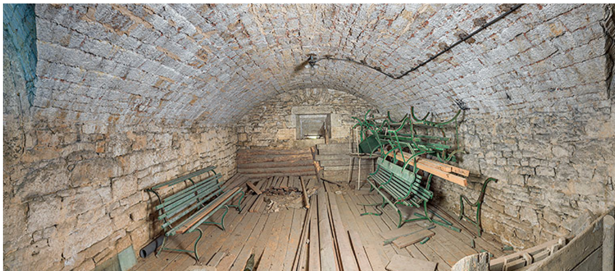
Vue générale d'une casemate.
