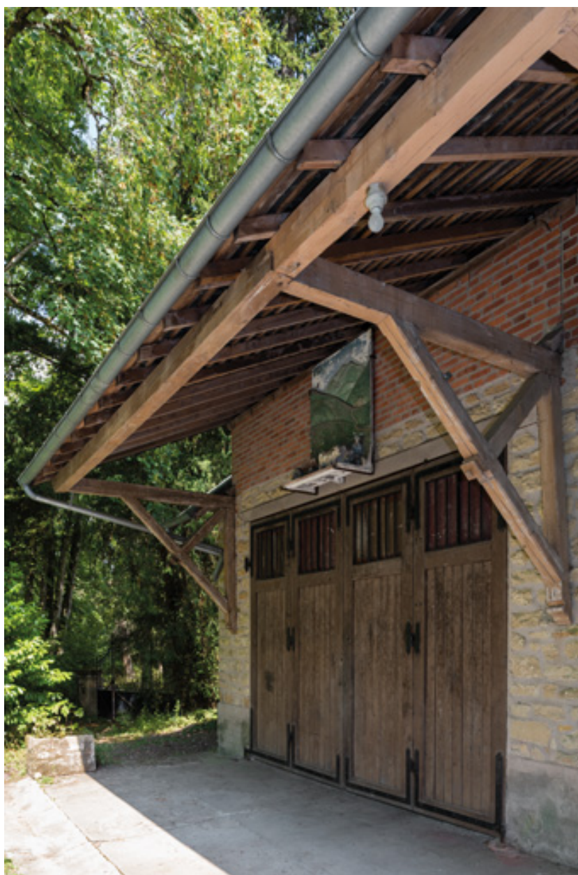
Entrée en façade nord-ouest.
