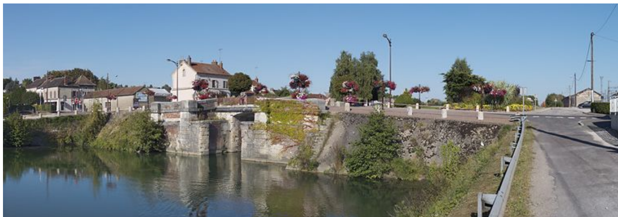
Pont routier à Migennes.
