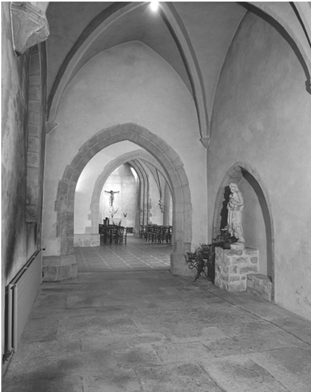
Eglise, quatrième chapelle gauche, vue depuis l'ouest.
