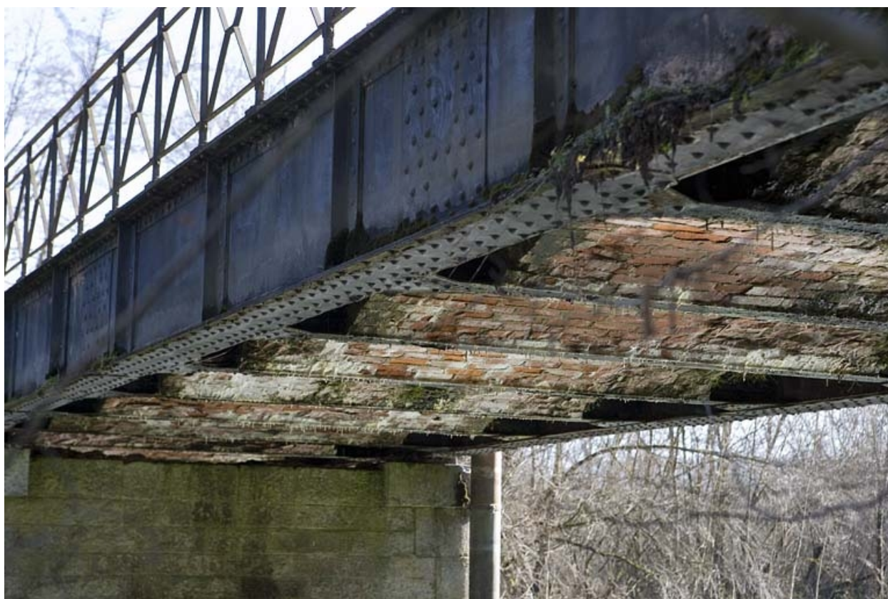
Voûtains en face inférieure du tablier.
