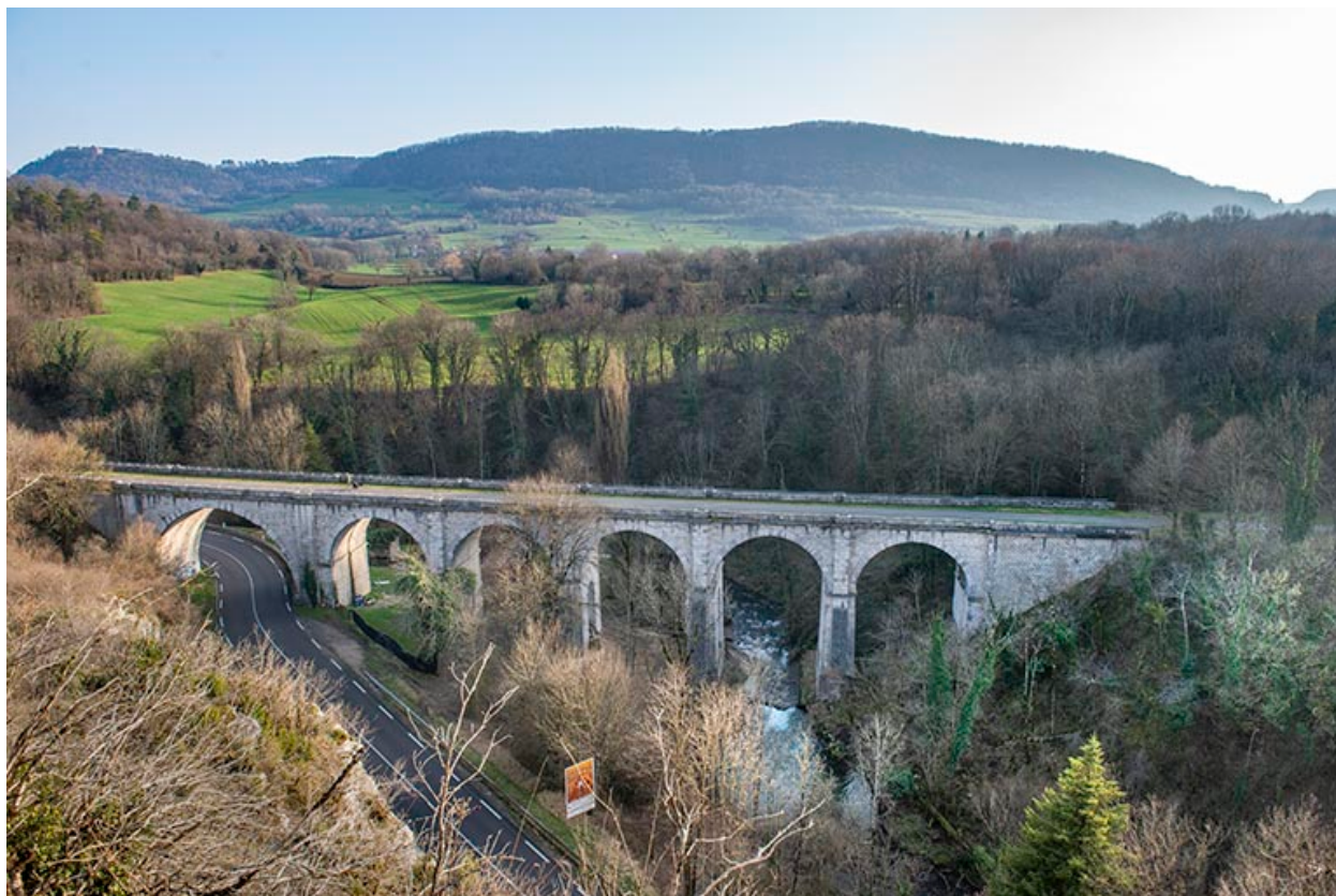
Vue du viaduc depuis le nord-ouest.
