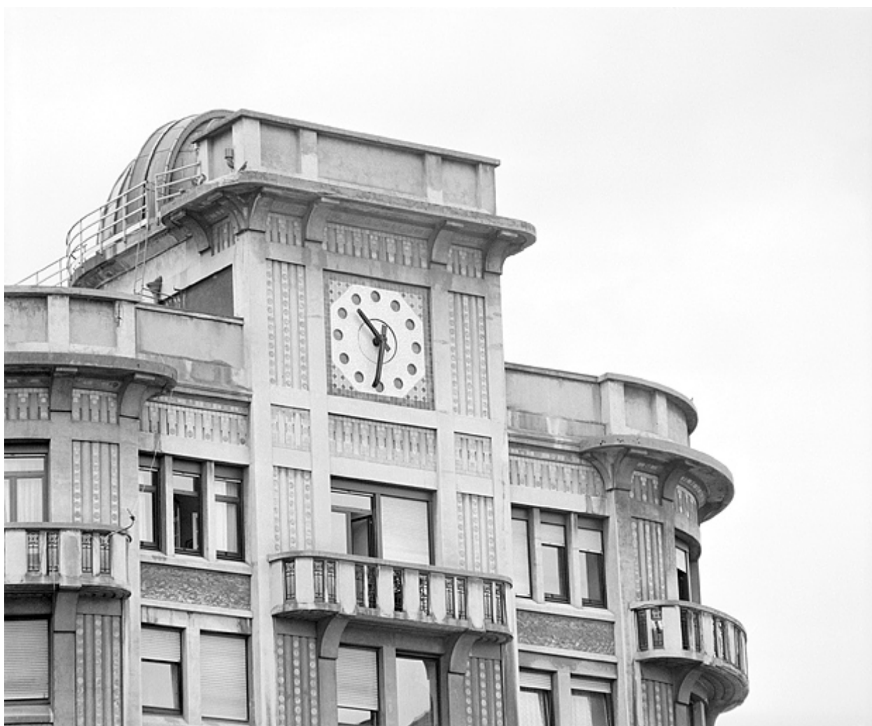
Partie supérieure du corps d'entrée et horloge.
