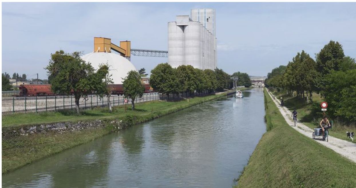
A Brienon-sur-Armançon, vue d'ensemble des silos avec accès par pont roulant au canal. A l'extrême-gauche, les voies SNCF.
