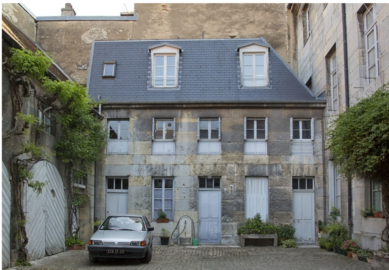
Vue de l'aile droite des communs.
