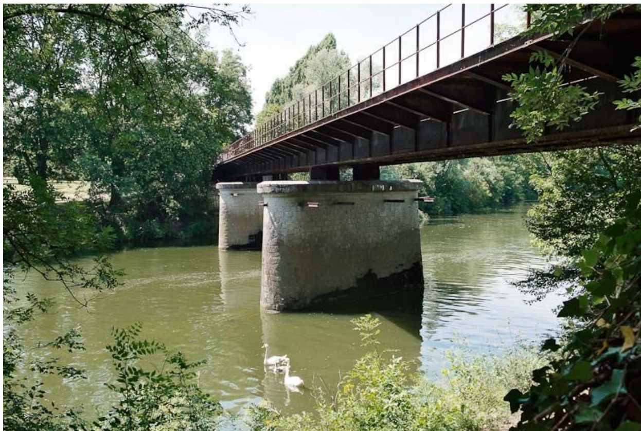
Pont de chemin de fer désaffecté.
