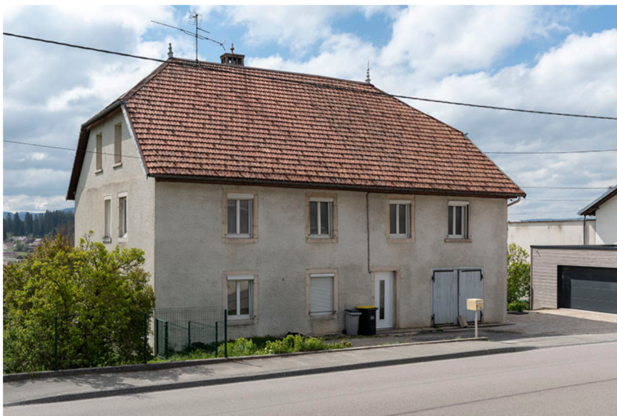
Façades antérieure et latérale gauche.
