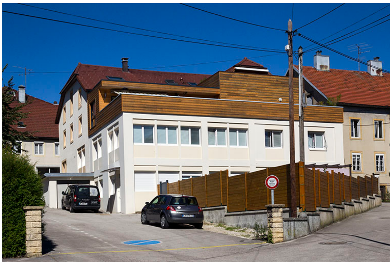
Façades postérieure et latérale droite.
