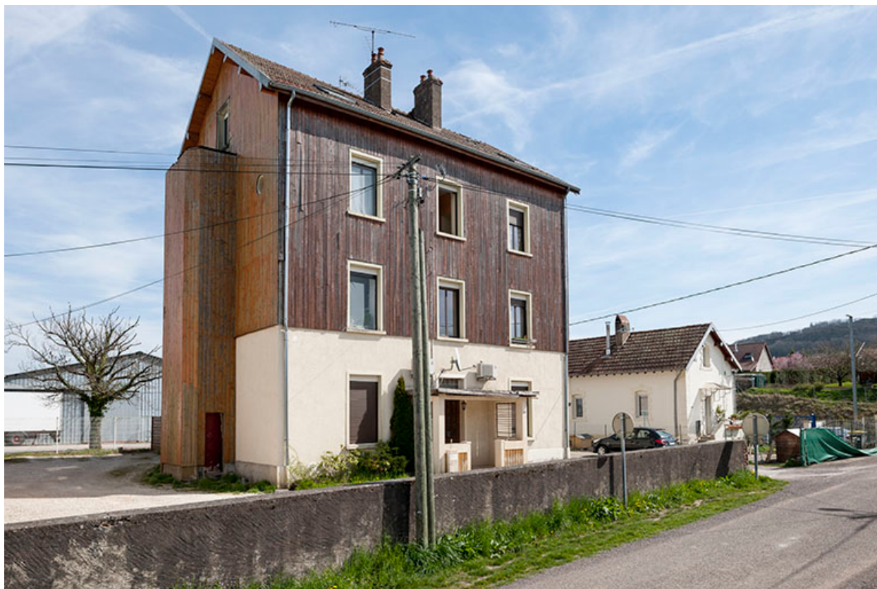
Ancien bâtiment de bureaux et logements.
