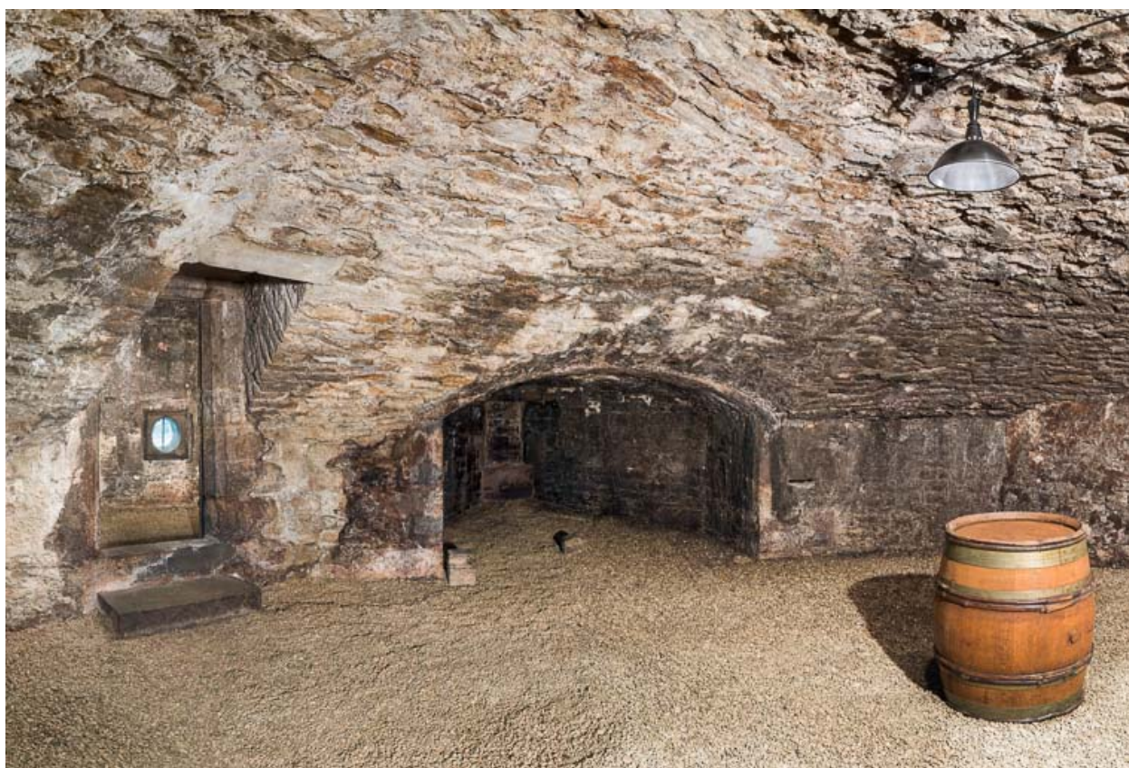
Casemate inférieure de la tour sud-ouest.
