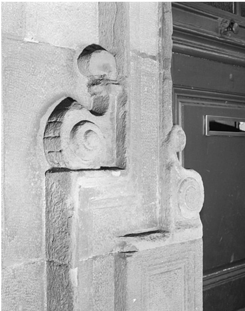
Façade principale. Détail de la porte centrale.
