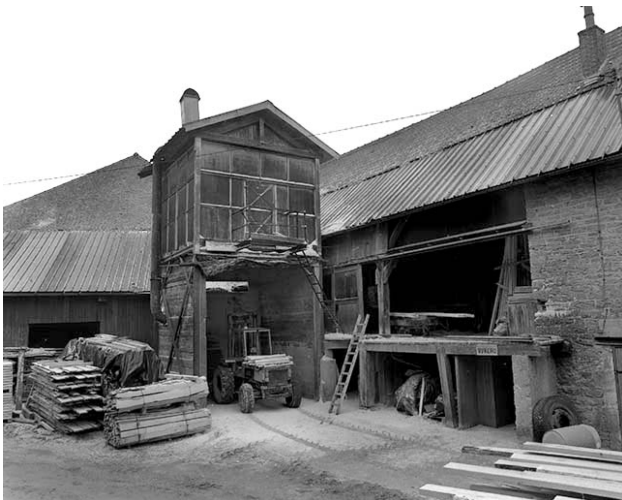
Silo à sciure et atelier de fabrication.
