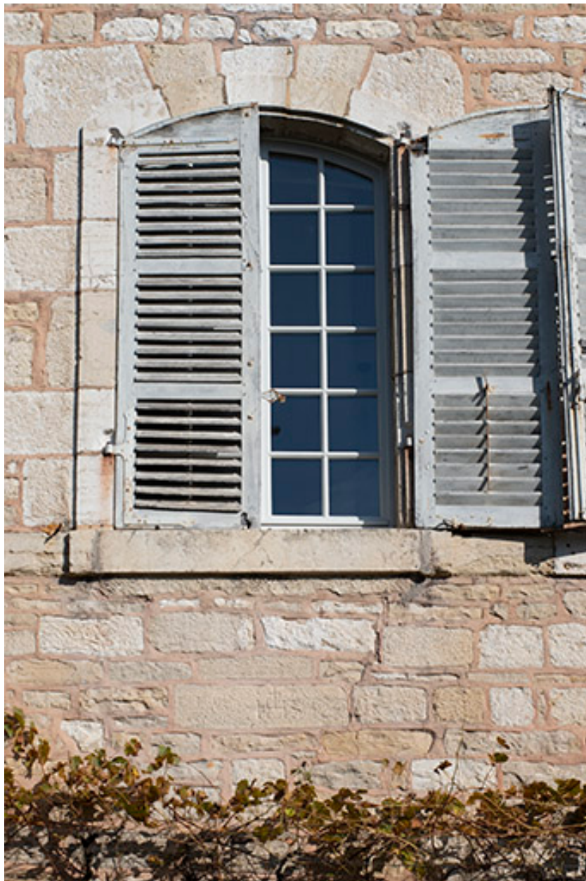
Fenêtre du rez-de-chaussée (façade ouest).
