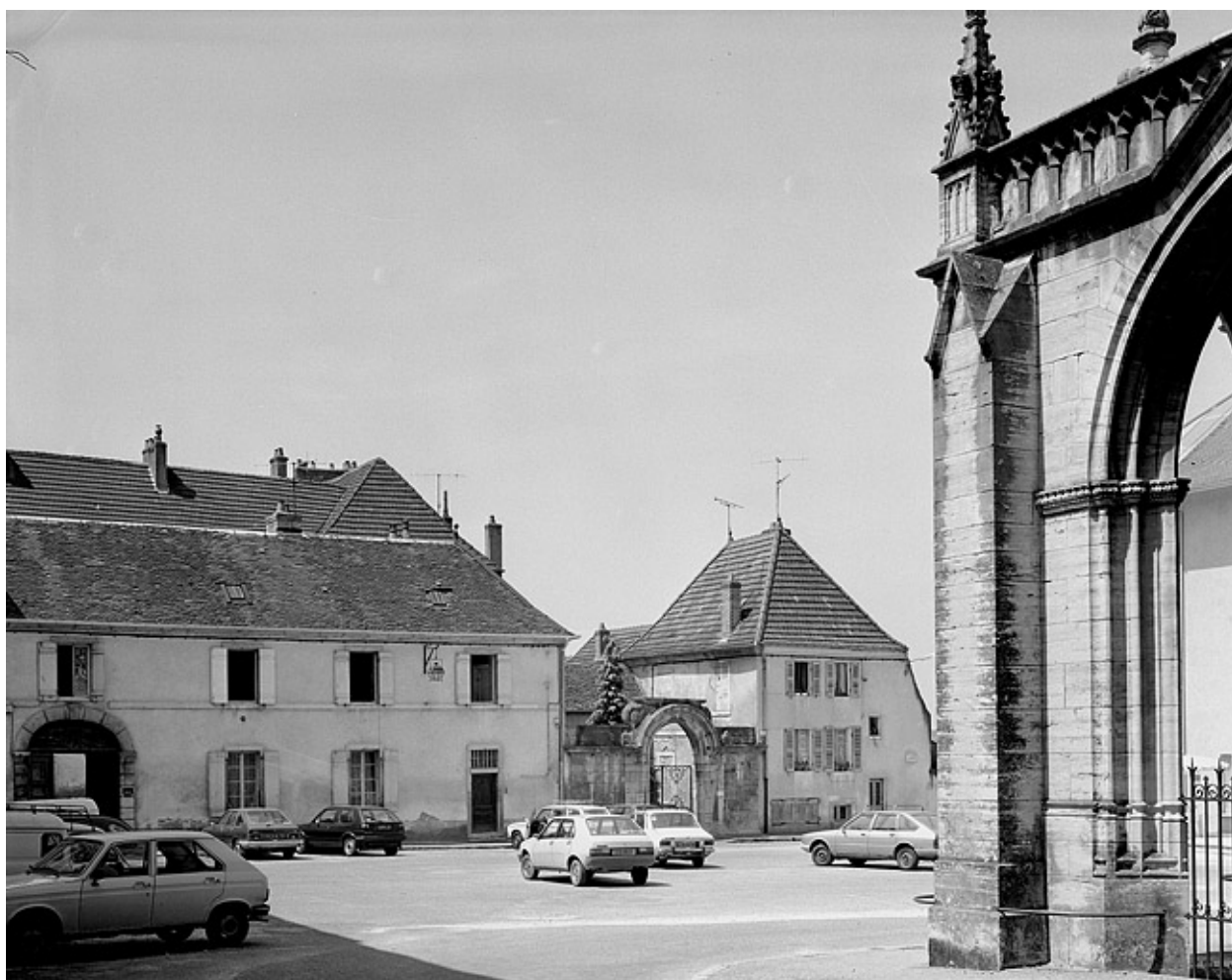
Façade antérieure : partie droite sur rue.
