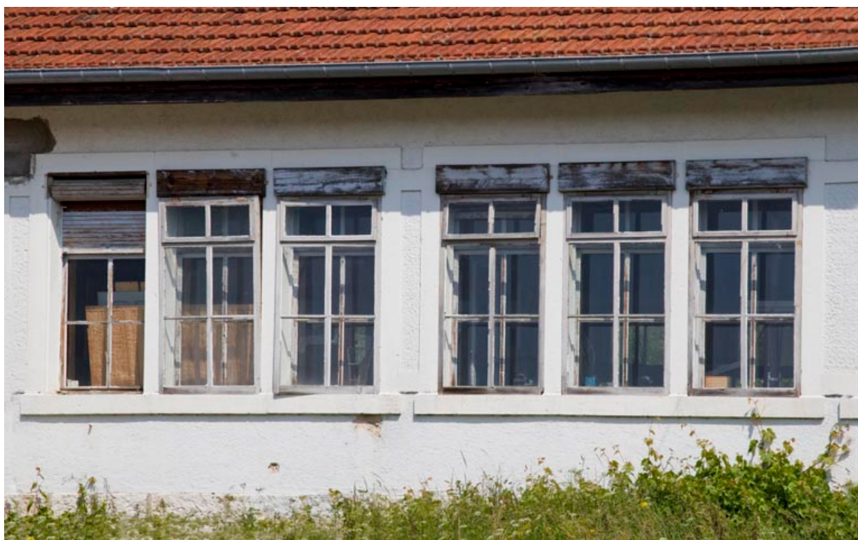
Détail des fenêtres de l'atelier.
