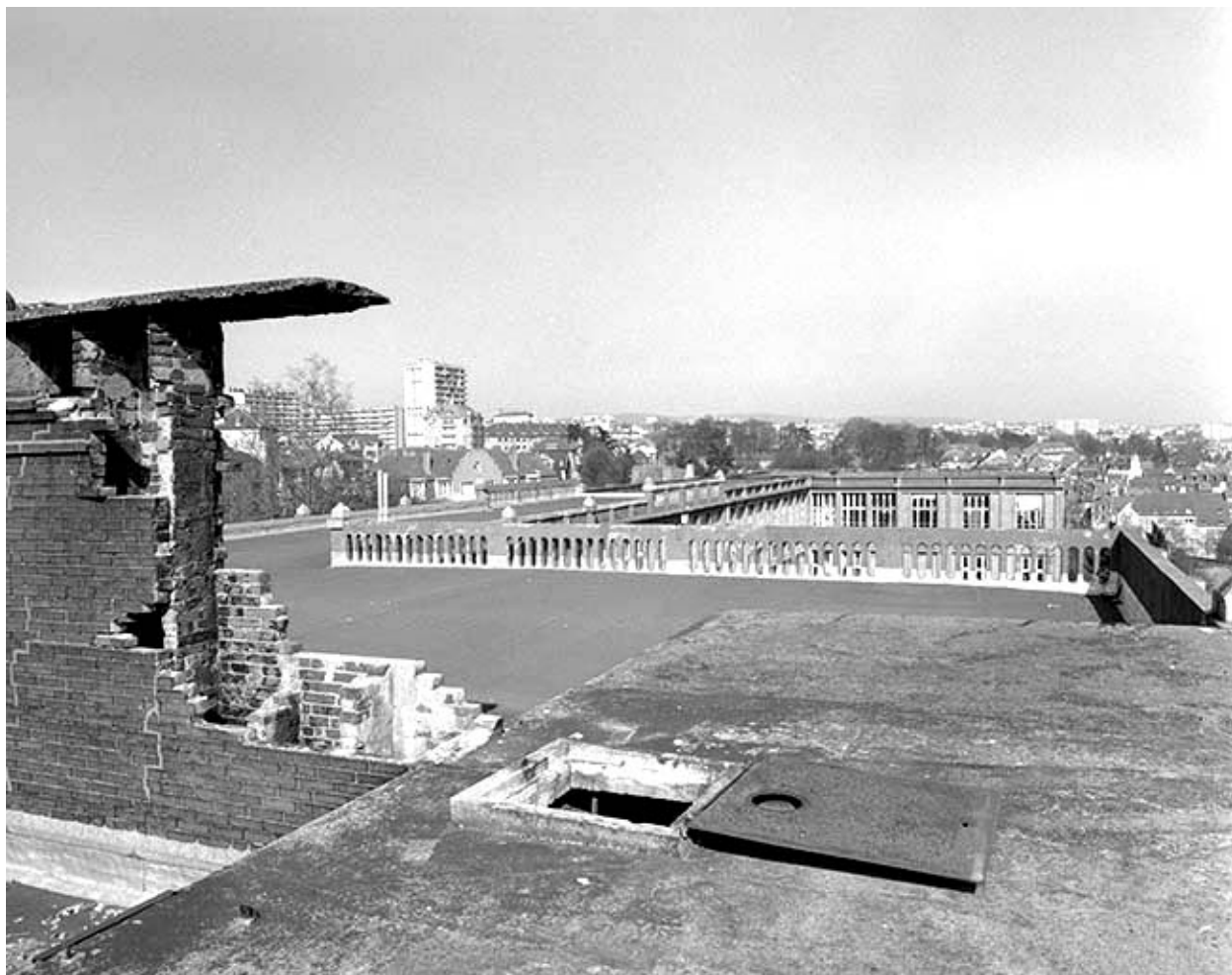
Toit terrasse des bâtiments (6, 8, 9).
