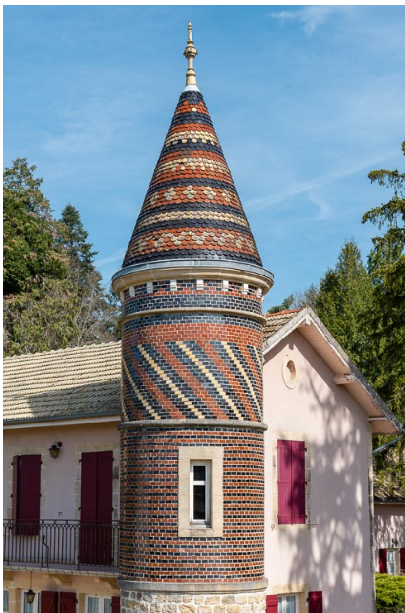
Détail de la tourelle d'angle.
