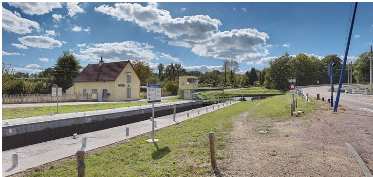
Site d'écluse pris d'aval.
