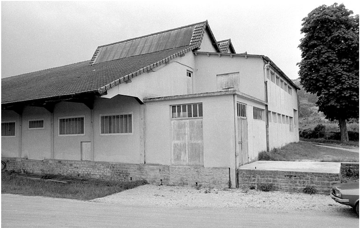
Extrémité ouest de l'atelier de fabrication.
