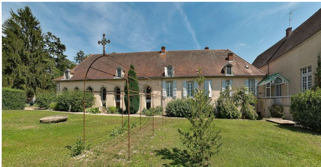
Façade postérieure de l'ancien hôpital.
