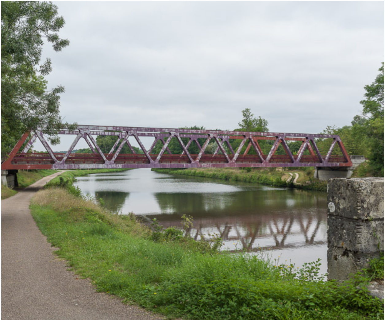
Vue du pont.
