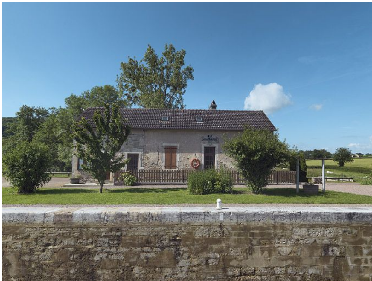
Maison éclésièr de face.
