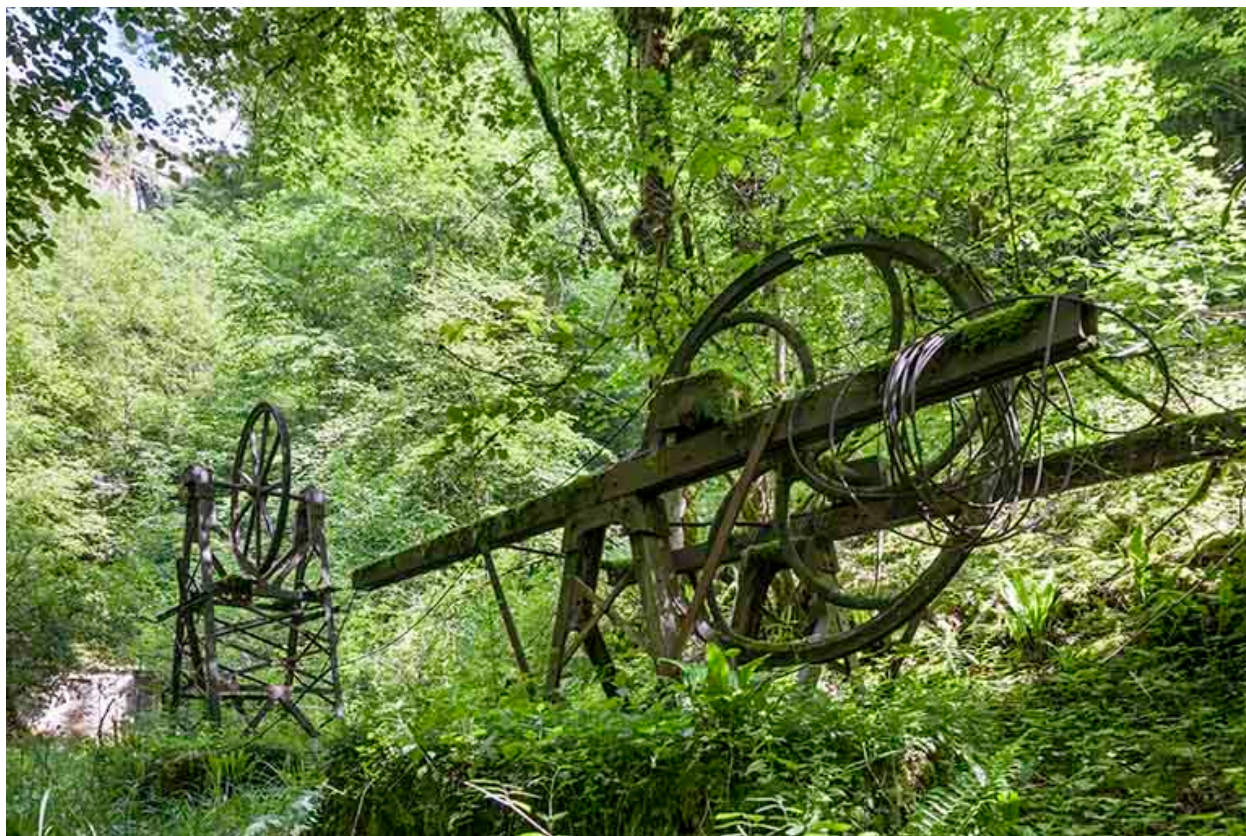
Supports métalliques de la transmission par câble.
