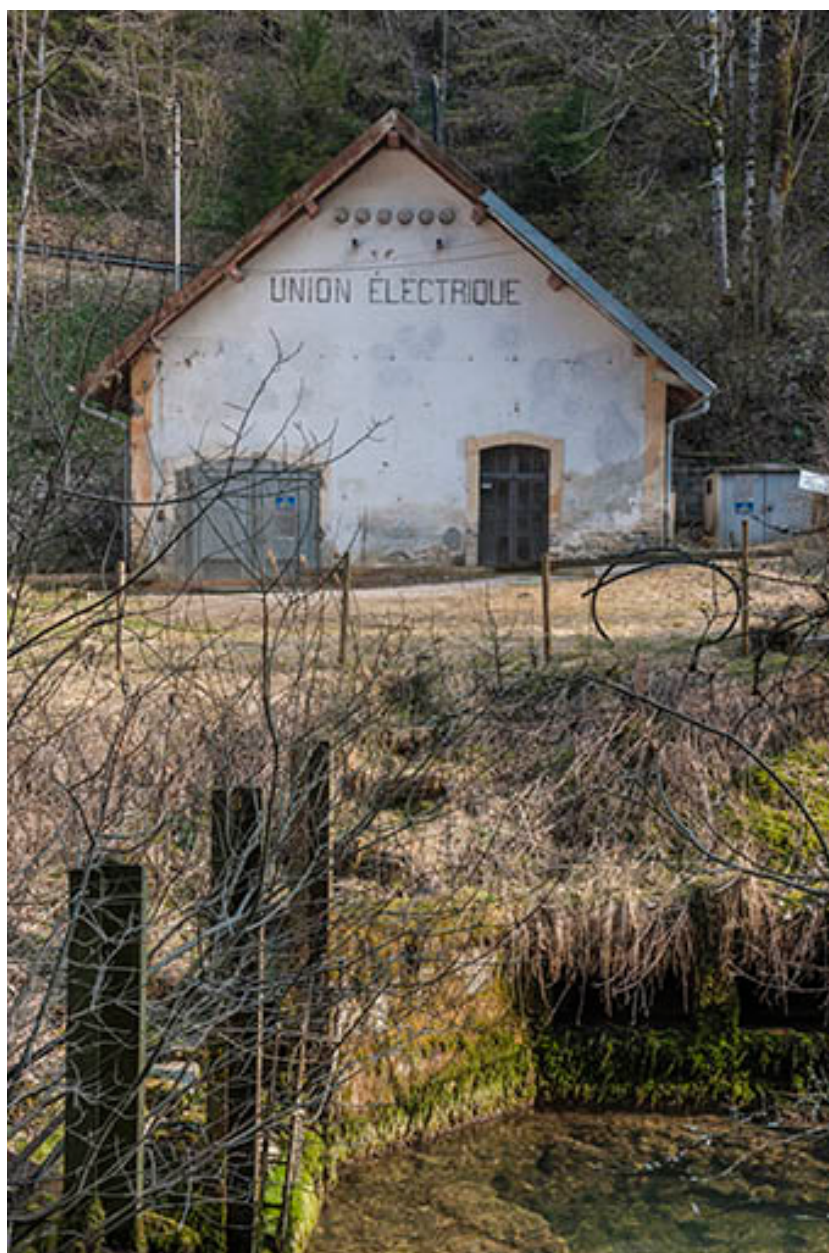
Centrale hydroélectrique du val de Consolation, Consolation-Maisonnettes.
