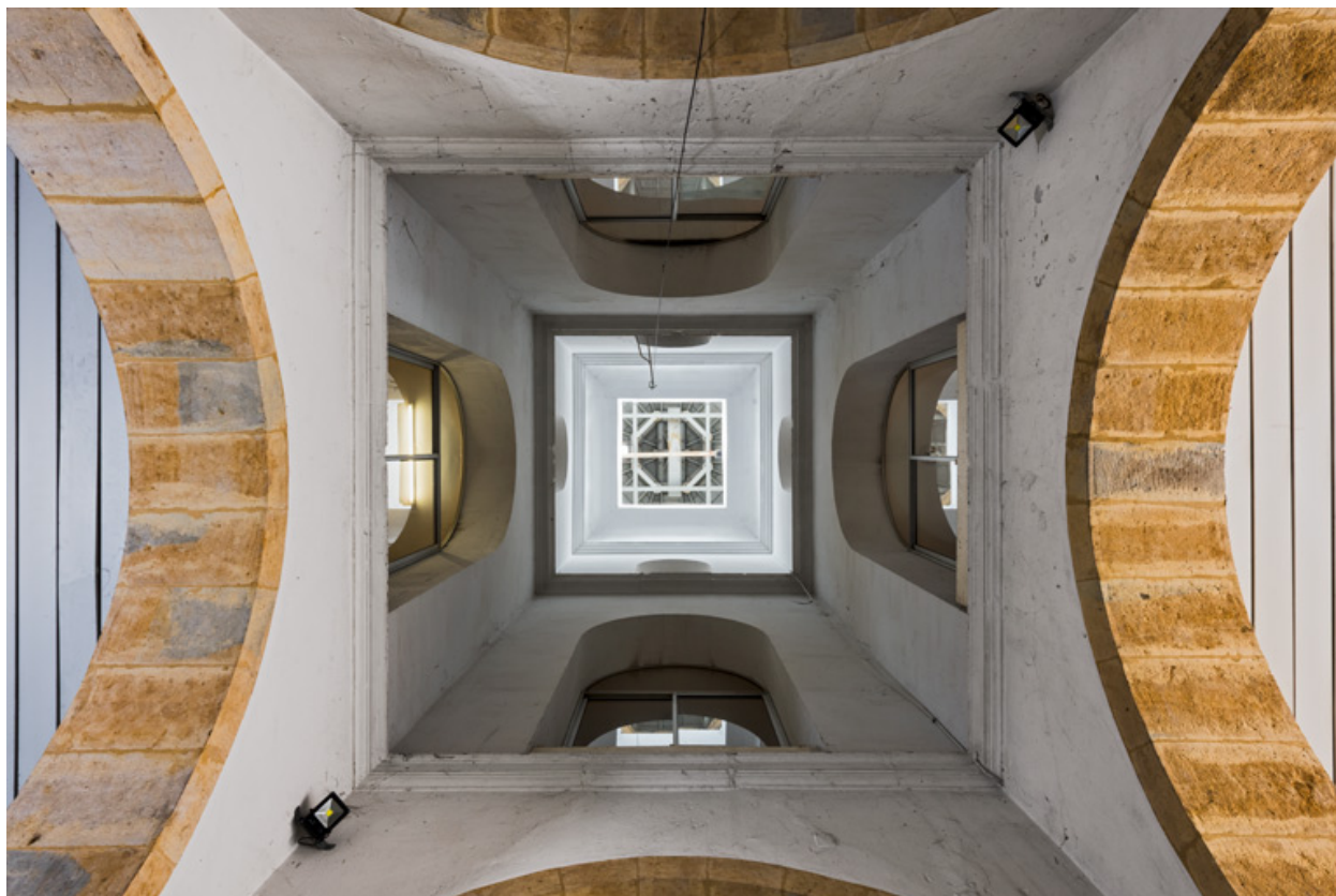
Rez-de-chaussée, halle : lanternon.
