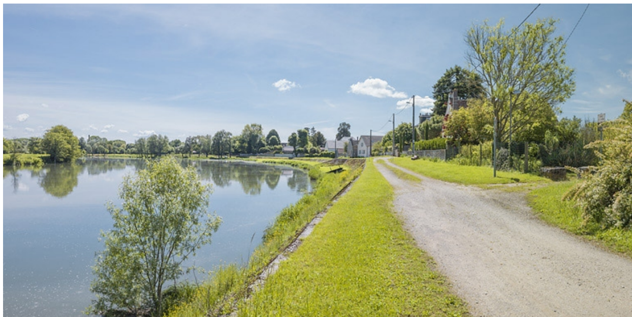
Vue d'ensemble de la digue, prise d'aval.
