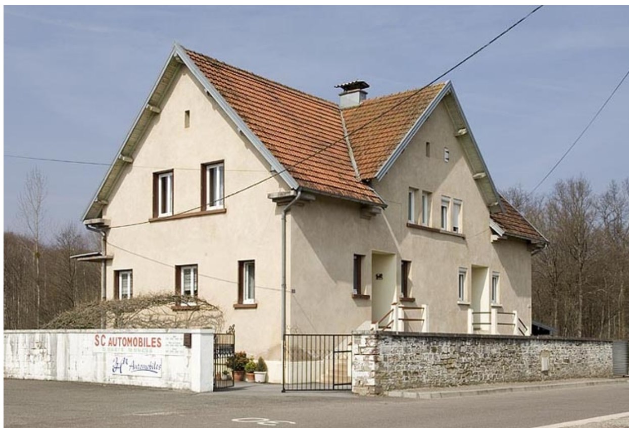
Logement de cadres (?). Vue de trois quarts.
