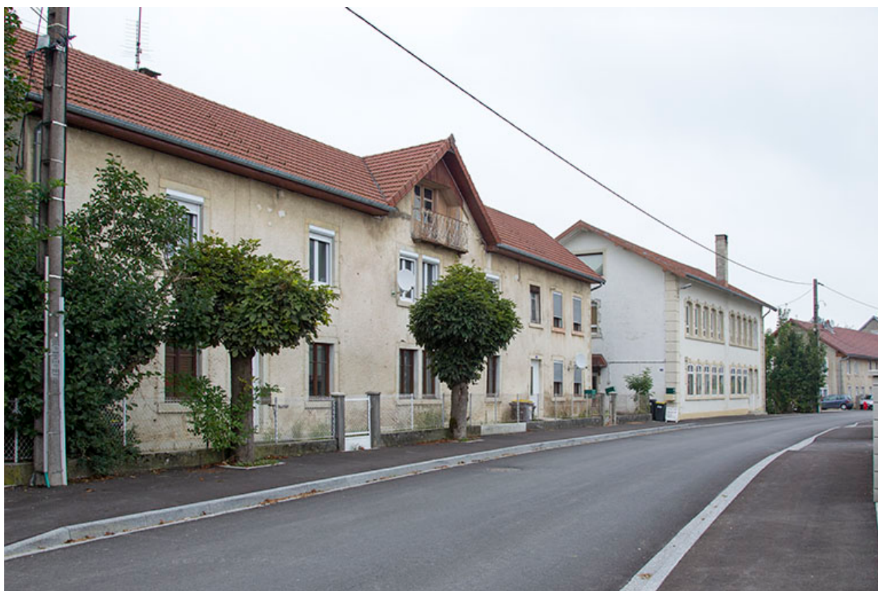
Vue d'ensemble, depuis le sud (façade antérieure).
