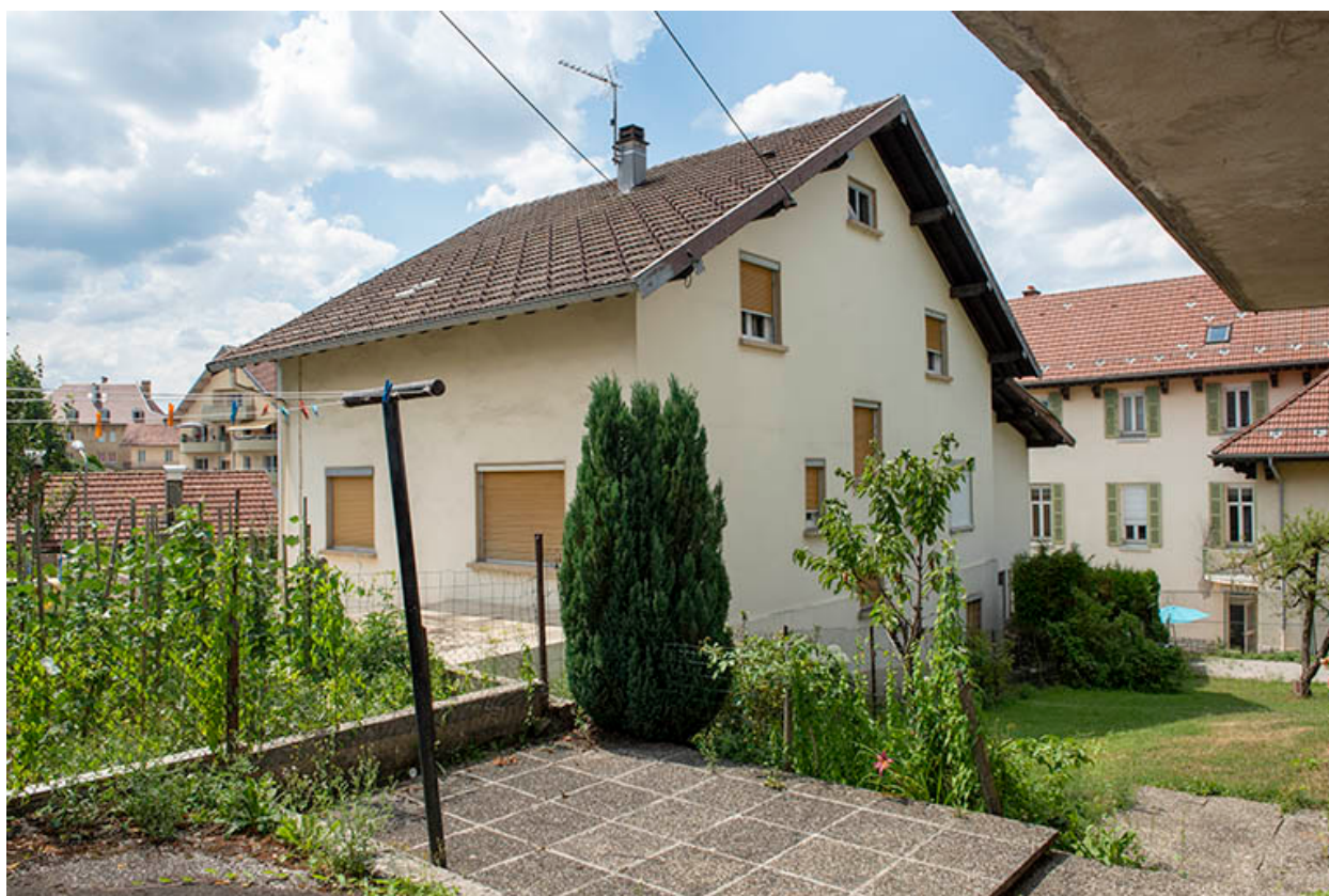
Maison : façades postérieure et latérale droite.
