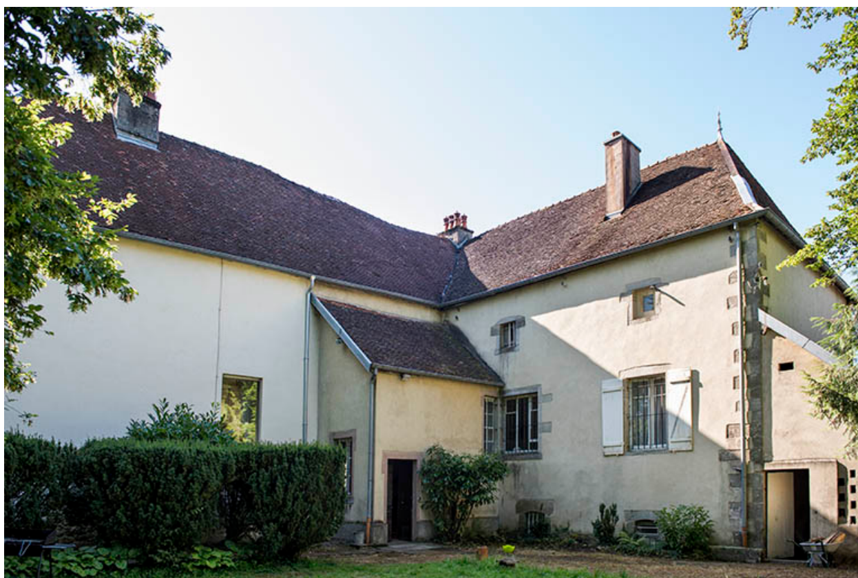
Les façades postérieures vues du nord.
