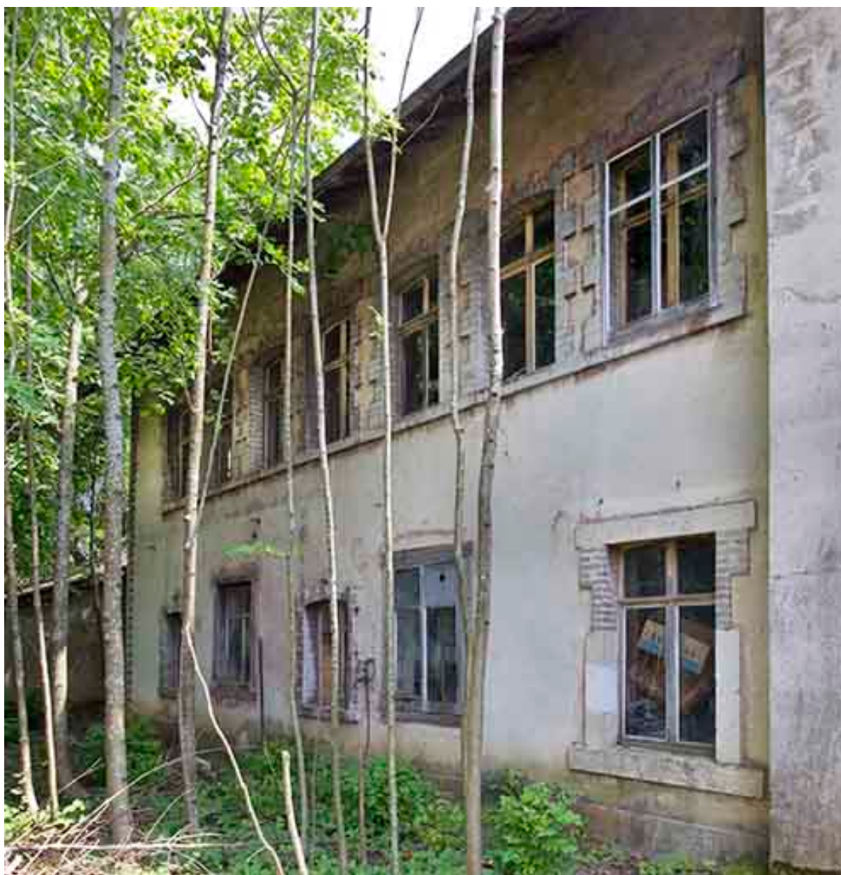
Atelier de fabrication occidental : façade postérieure.
