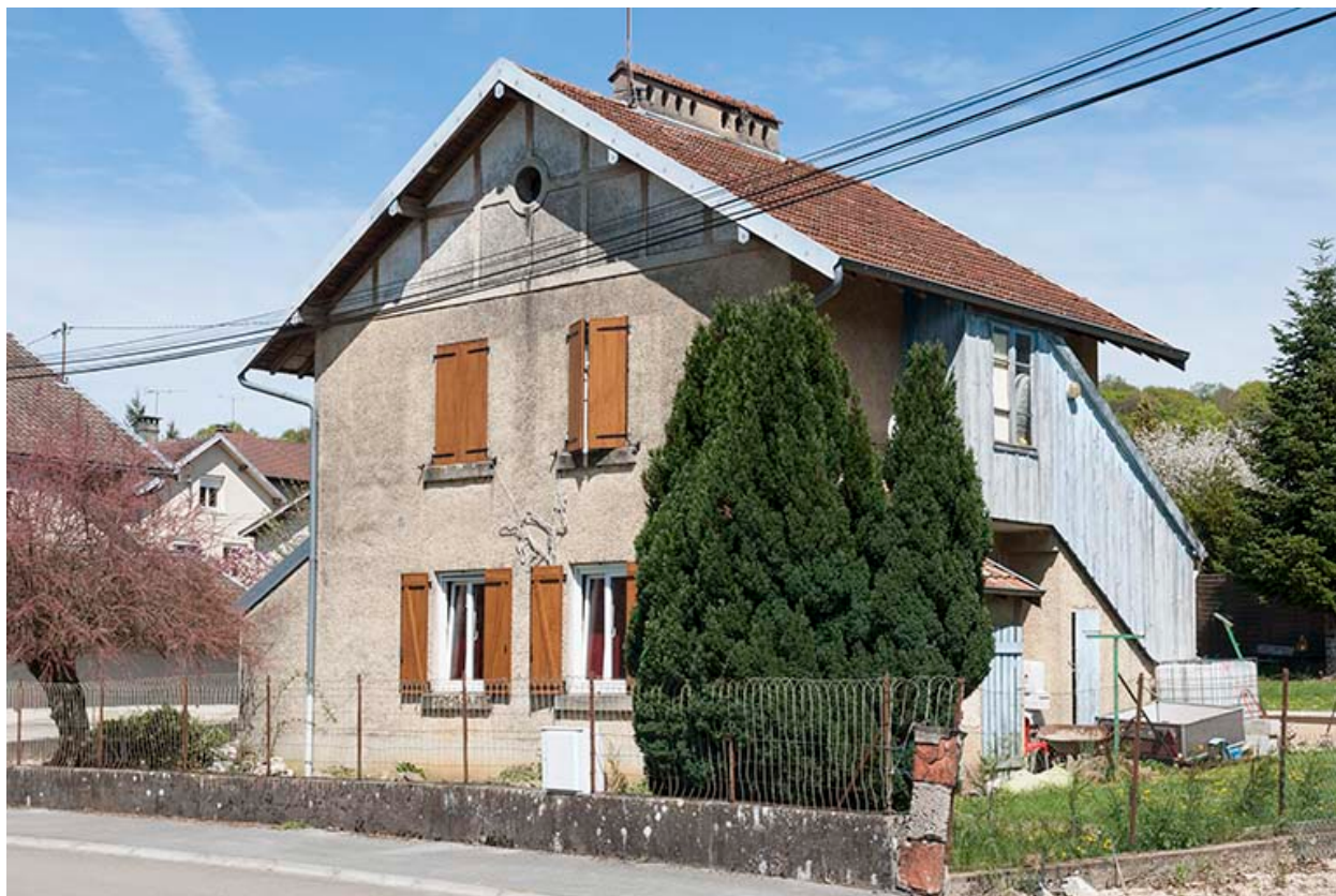
Maison jumelée (21 rue des Salines).
