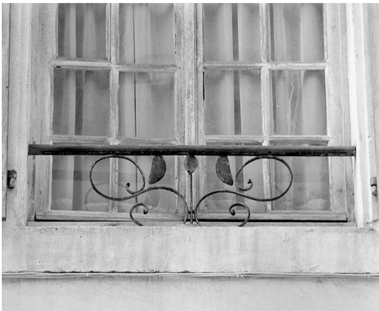
Façade sur rue. Détail d'un balconnet.
