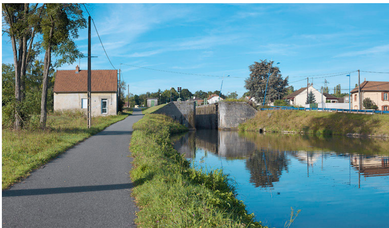
Site de l'écluse 02 depuis le bief 03.
