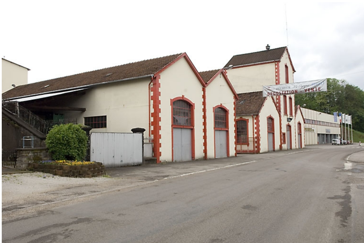
Bâtiments industriels. Vue depuis le nord-est.
