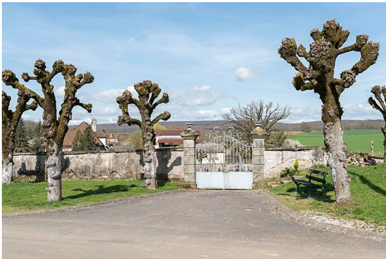
Grille d'entrée et mur d'enceinte du cimetière.
