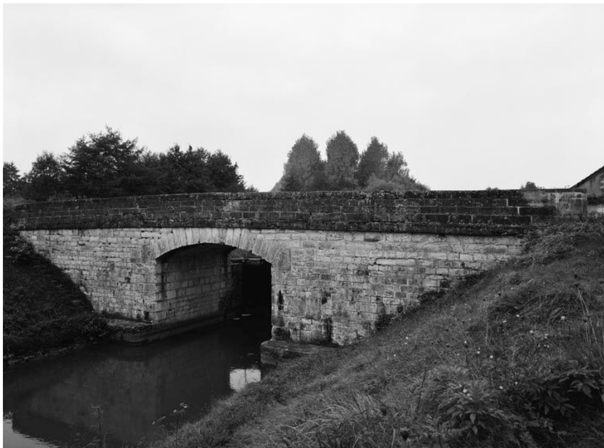
Pont sur écluse.
