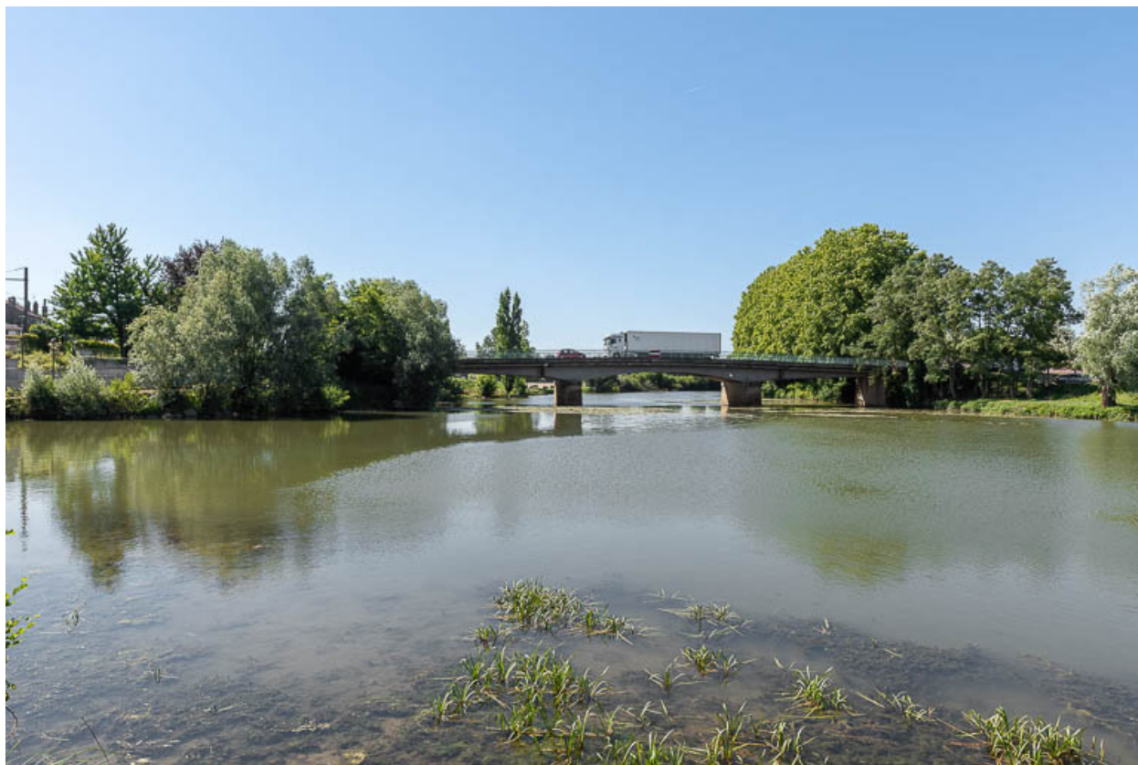
Vue générale du pont et du site.
