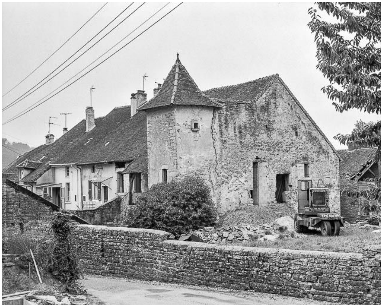
Maison de vigneron située place Jean-Moulin.
