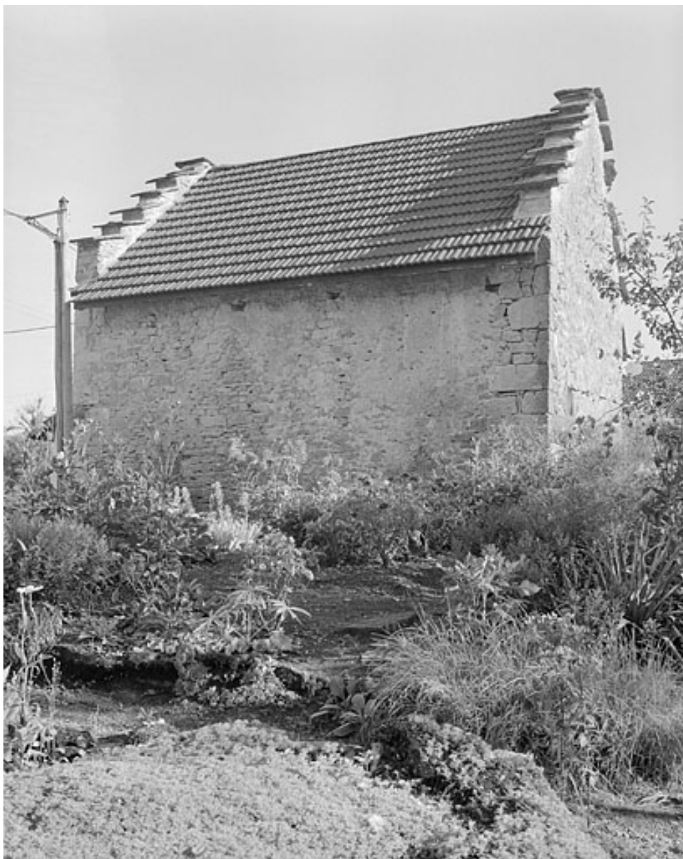
L'ancienne fromagerie de Ponthoux, face sud.
