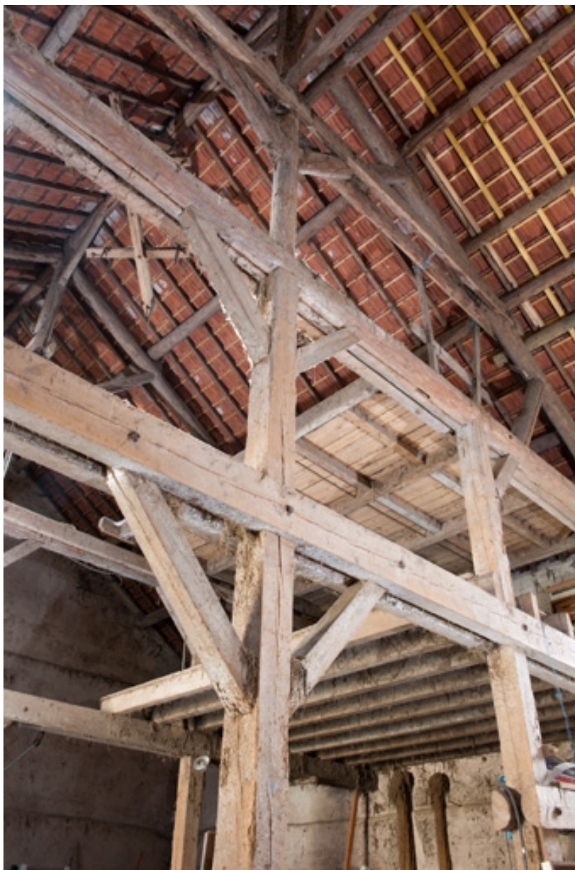
Grange : vue de la charpente.
