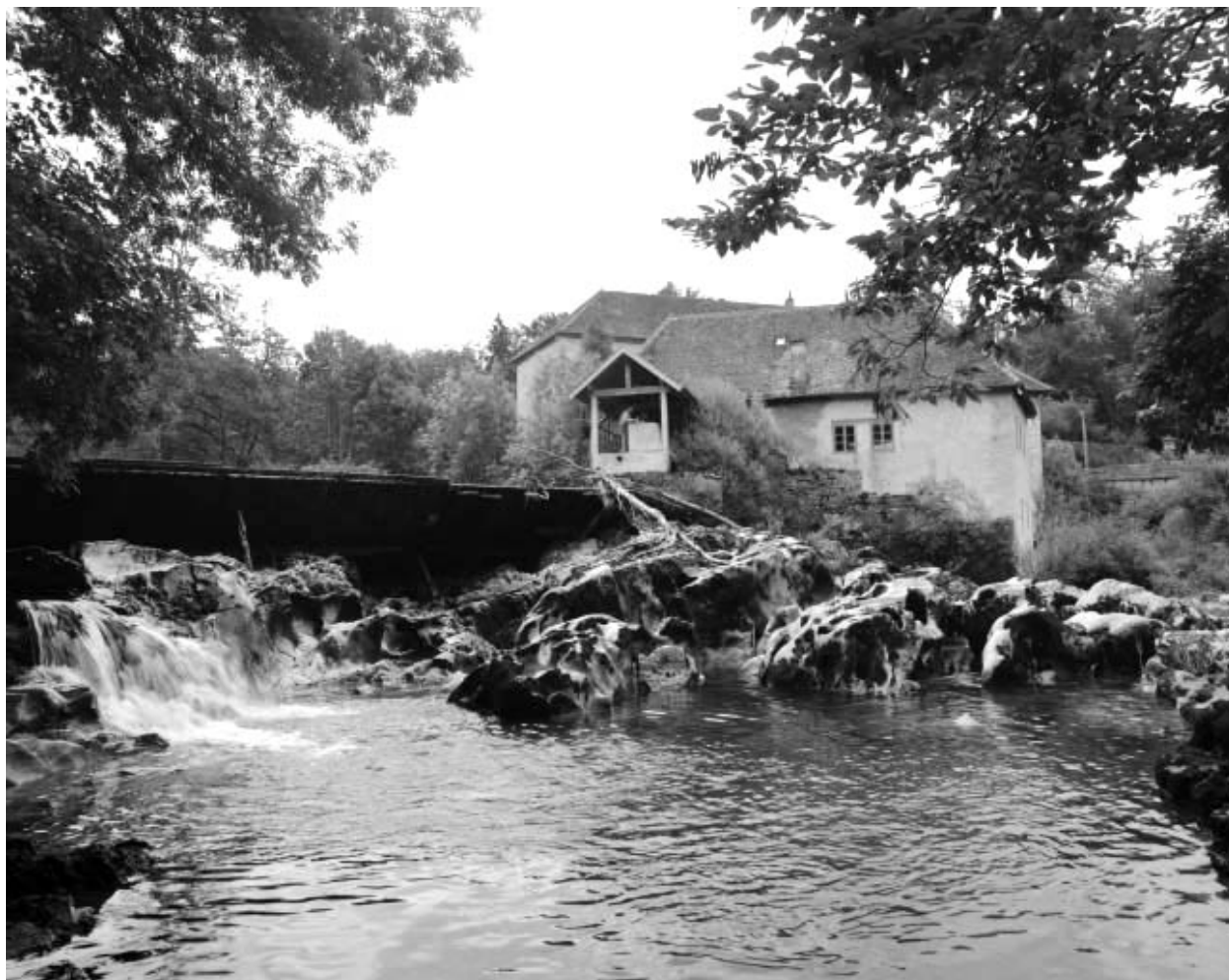
Barrage et scierie depuis le nord-ouest.
