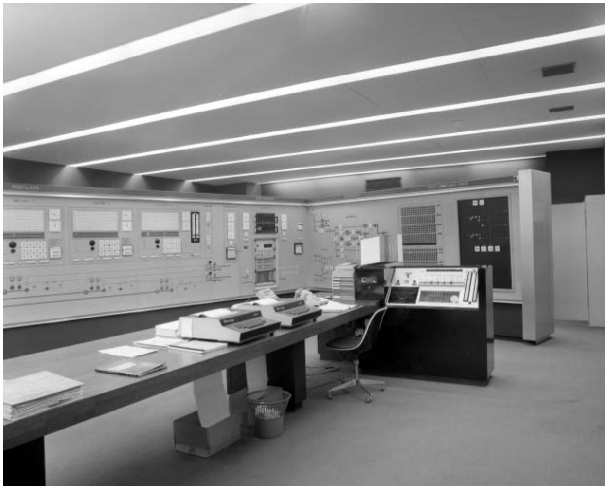
Vue d'ensemble de la salle de commande.
