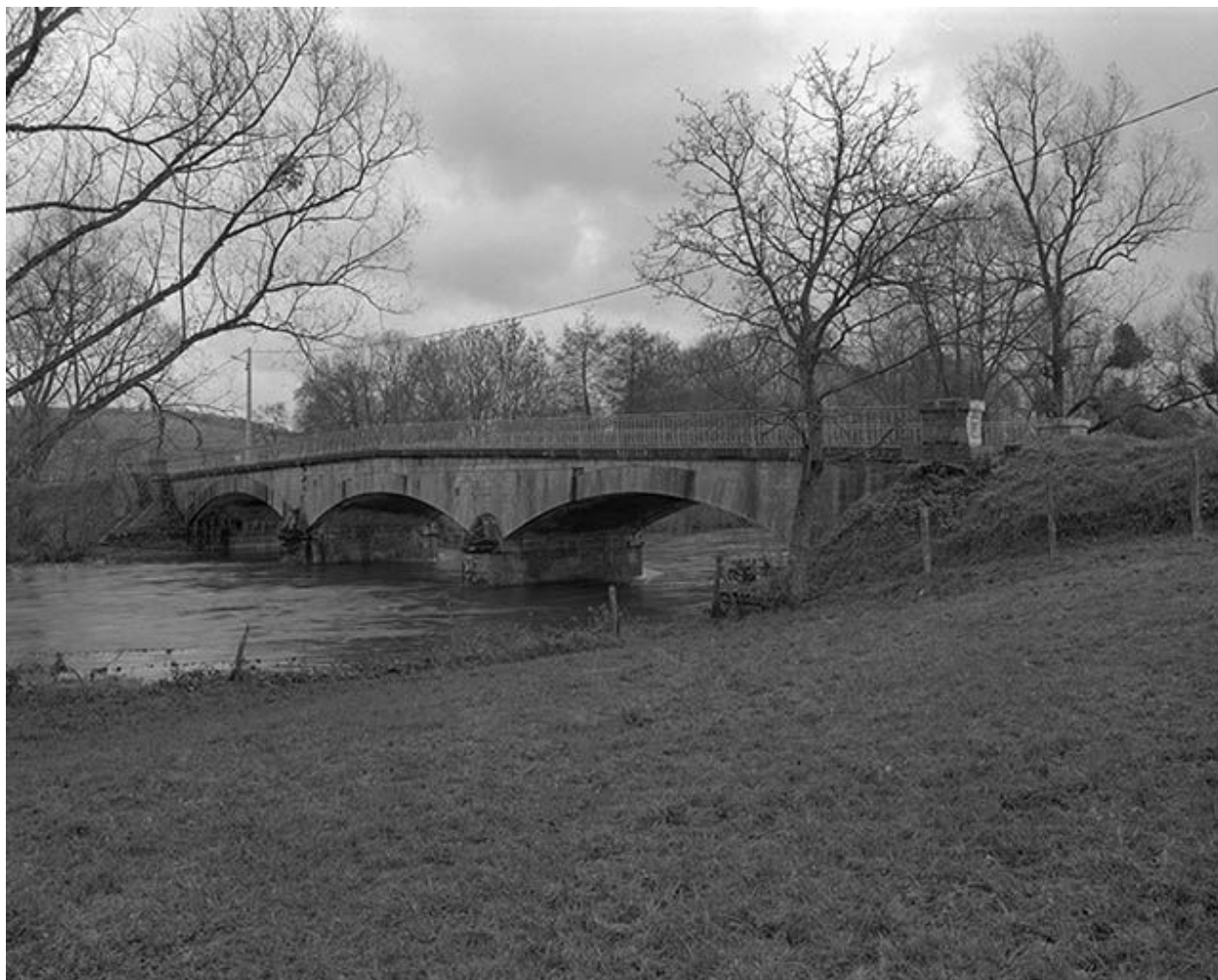
Vue d'ensemble prise de l'aval.
