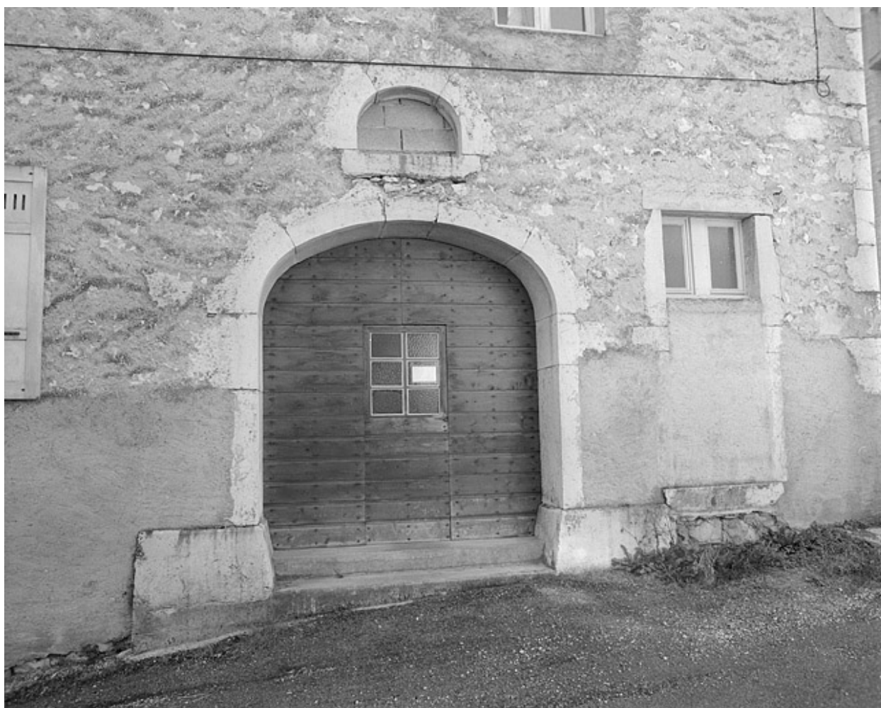
Bureau : porte dans le mur pignon nord-ouest.
