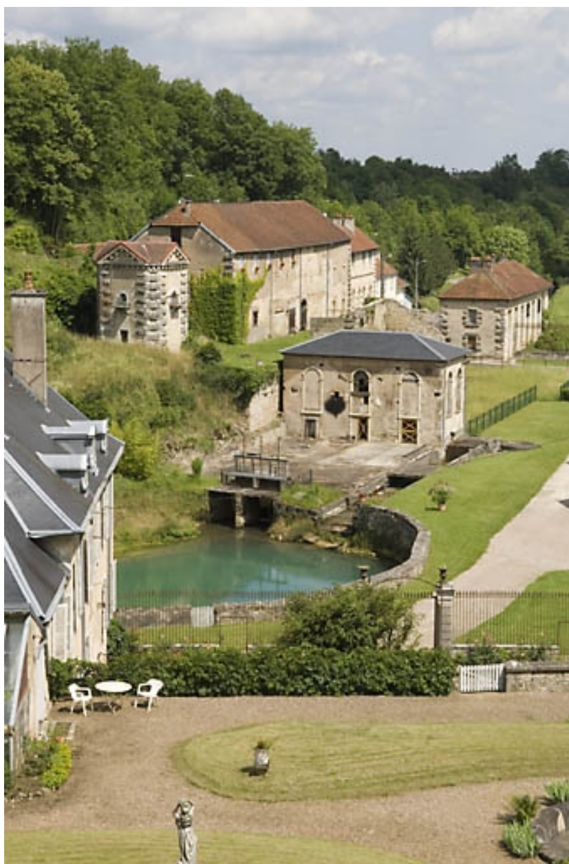
Vue plongeante depuis le parc du logement patronal, à l'est.
